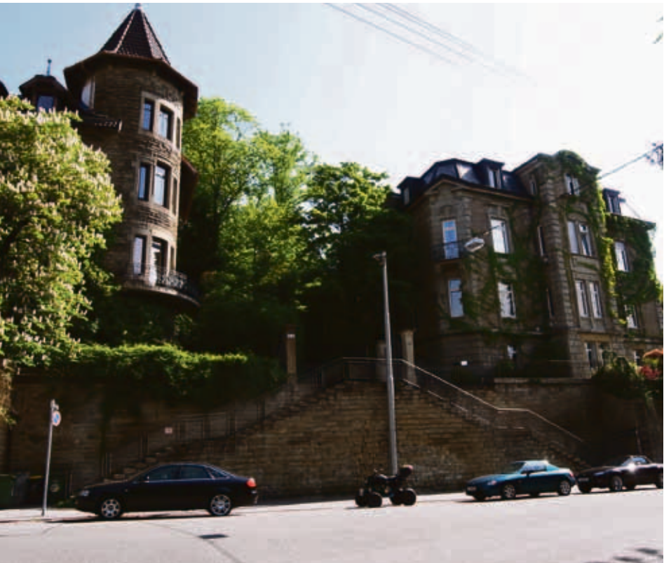
Der markante Zugang zur Oscar-Heiler-Staffel zwischen Hohenzollern- und Humboldtstraße.
